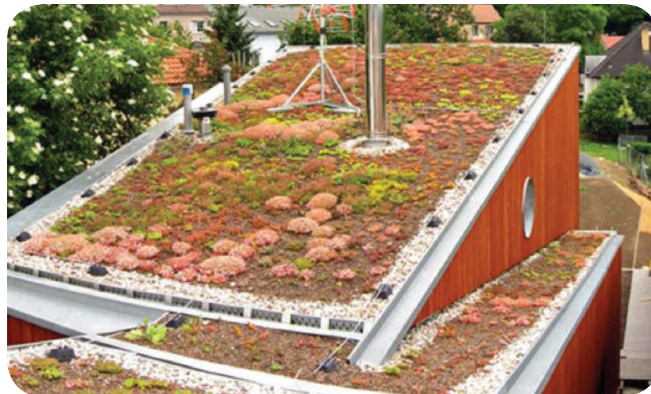
Obr. 27: Extenzivní zelená střecha, Dům v úžině, Praha-Jinonice / Foto Pavel Dostál, 2015
