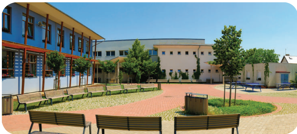
Obr. 26: Pasivní a nízkoenergetická Základní škola a mateřská škola Praha-Slivenec s extenzivní zelenou střechou a polopropustnou dlažbou / Zdroj: skolaslivenec.cz
