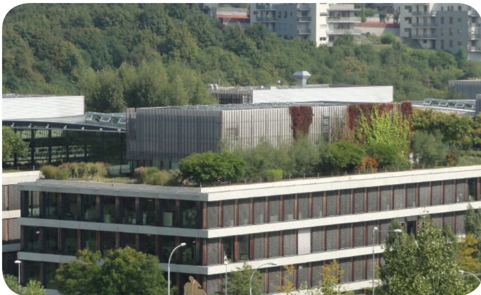
Obr. 25: Intenzivní zelená střecha a vegetační zastínění a další úsporná zařízení na budově ČSOB Radlická / Zdroj: http://www.csob.cz
