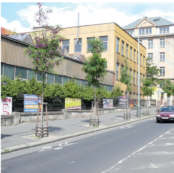
První etapa celkové rekonstrukce stromořadí ve Vršovické ulici, Praha 10
