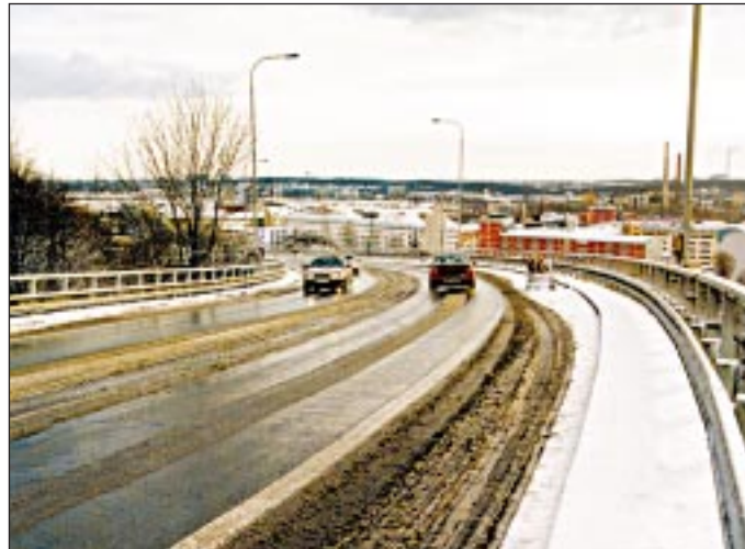
Rekonstrukce vysočanského mostu bude rozsáhlá a technicky náročná.
