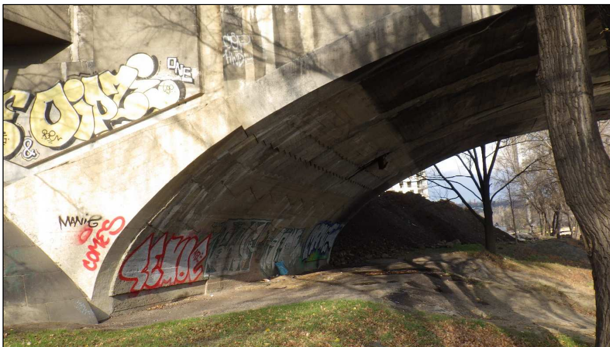
Obr. 13: Jižní pohled na pilíře, mezi 1. a 2. obloukem - patu druhého oblouku na levém břehu Vltavy – Holešovice, zřetelné hranice hladiny z povodní 2002
