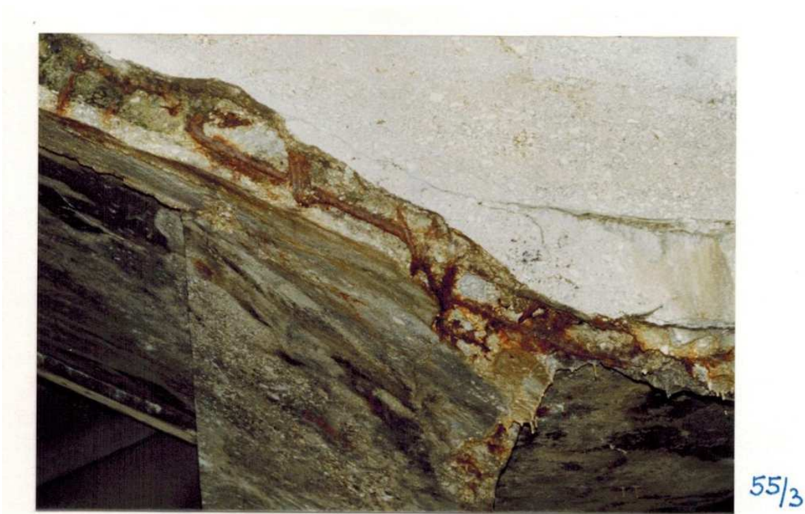
Obr. 14 Stav konstrukce v roce 1995 dle podkladu [2]
