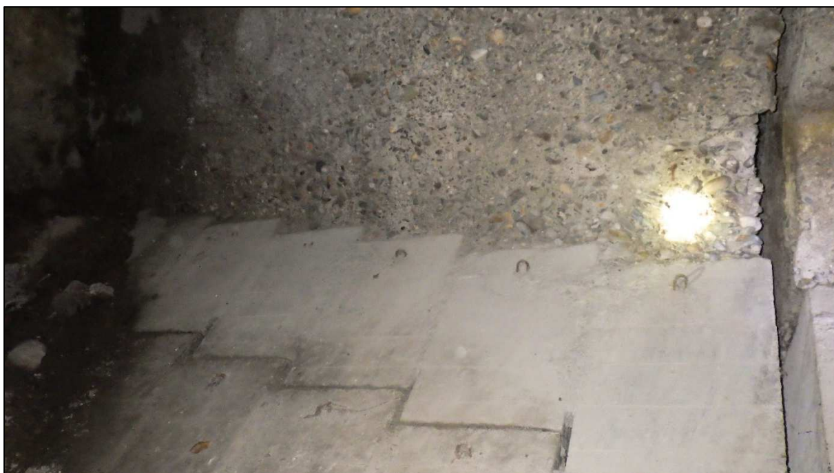
Obr. 12: Volná podélná spára mezi jednotlivými pásy oblouku, pohled z rubu, v komoře nekrytá a bez utěsnění
