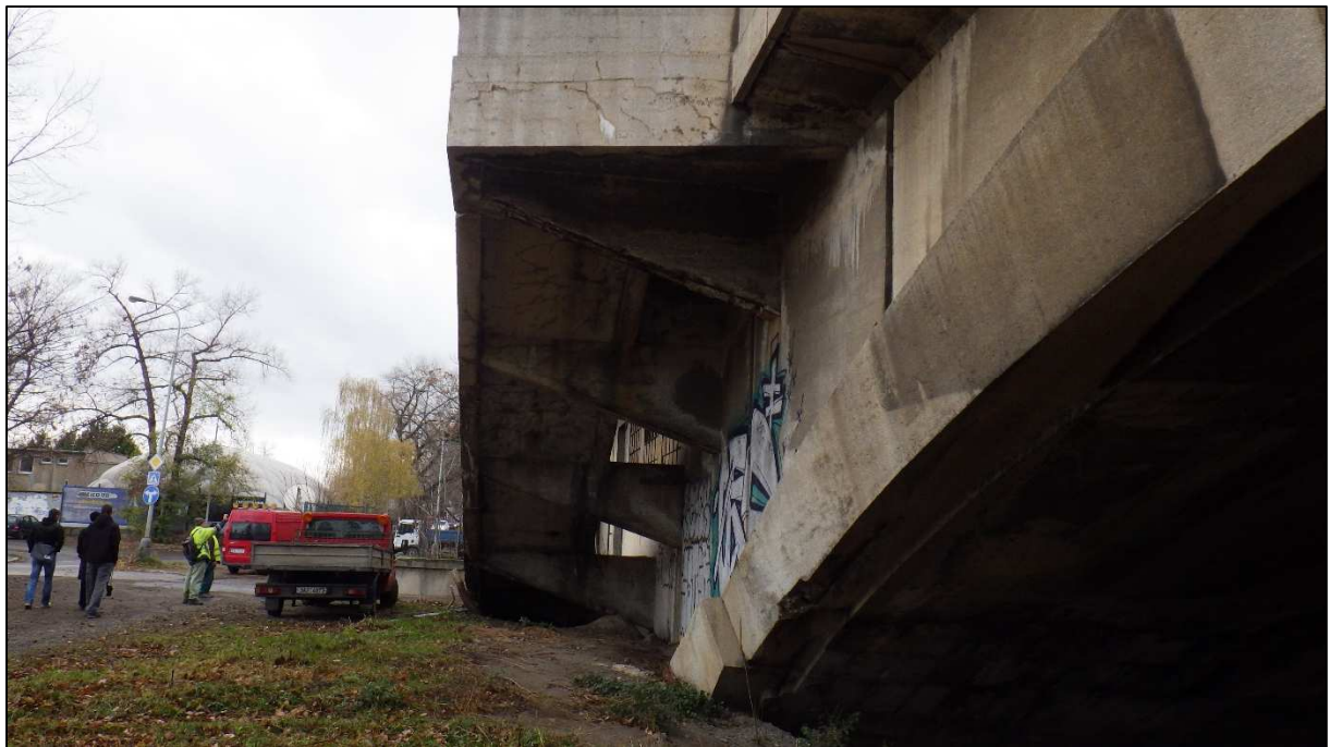
Obr. 27: Jihozápadní pohled na patu oblouku s narušeným žb. schodištěm na jižní straně, schodiště, vyšší výška terénu vně mostu (cca 0,6m)
