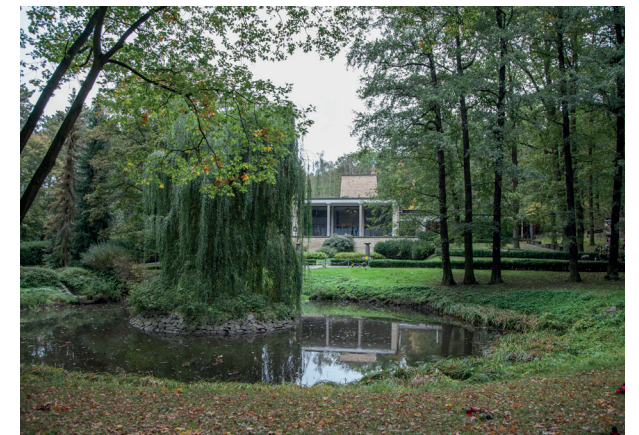
048 Úprava prostranství před smuteční obřadní síní – vodní plochy jsou nedílnou přirozenou součástí rozptylové loučky [ Praha 5, Motolský hřbitov ]
