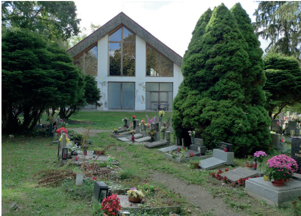
052 Konverze obřadní sáně na galerii moderního umění je dobrým a zároveň výjimečným příkladem využití objektu [ Volyně, hřbitov Malsička, Galerie Na shledanou ]
