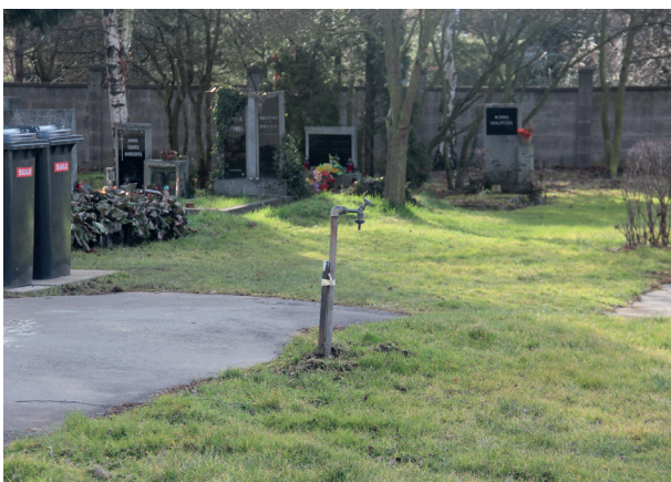
088 Samotný zdroj užitkové vody bez příslušenství, zejména pevné podložky pro umístění nádoby, není dostatečný [ Praha 5, Košířský hřbitov ]
