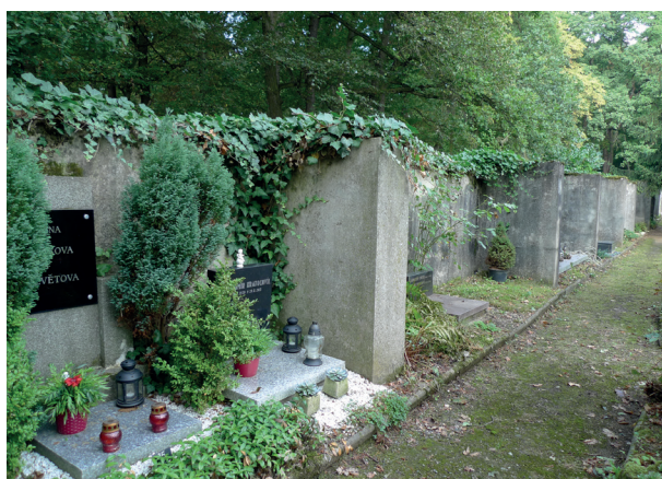
029 Vhodné tvarování vnitřního líce zdi umožňuje umístění urnových hrobů a podporu intimity jednotlivých hrobových míst [ Praha 16, Chuchelský hřbitov ]
