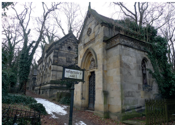
153 Opuštěná kaplová hrobka rekonstruovaná správcem pohřebiště na kolumbární objekt [ Praha 3, Olšanské hřbitovy ]
