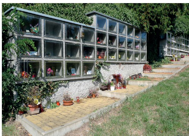
156 Zeď kolumbária na svažitém terénu – výška podezdívky je optimální, stejně tak odstupňování přístupového chodníku [ Kamenný přívoz ]
