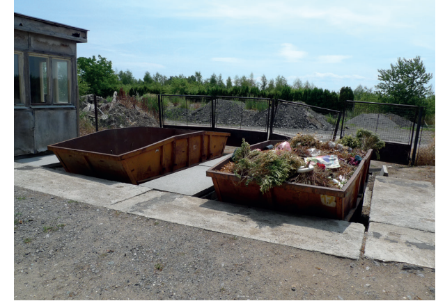
055 Hospodářský dvůr mimo areál hřbitova; polozapuštěné kontejnery, resp. rampa umožňuje pohodlnou manipulaci [ Poděbrady, Kluk ]
