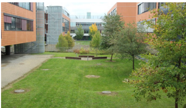
Vsakovací průlehy s retenčními rýhami mezi pavilony kampusu Masarykovy univerzity v Brně-Bohunicích (zdroj: www.tzb-info.cz ).
