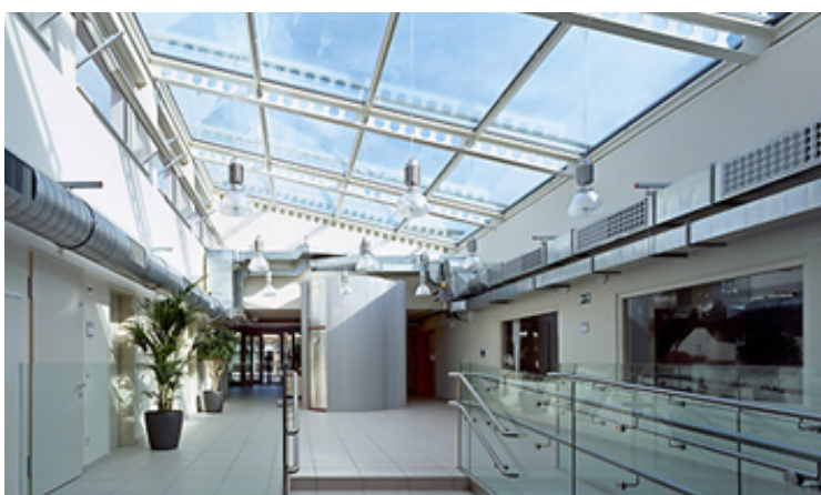
Interiér pasivní mateřské školy ve Vídni, Schukowitzgasse, architekt Georg W. Reinberg, 2006. Systémy technických zařízení budov, rozvody vzduchotechniky, technická místnost atp. jsou součástí designového konceptu interiéru a mohou být využity jako součást interaktivní výuky v rámci konceptu „School as a Teaching Tool“ (zdroj: www.reinberg.net ).
