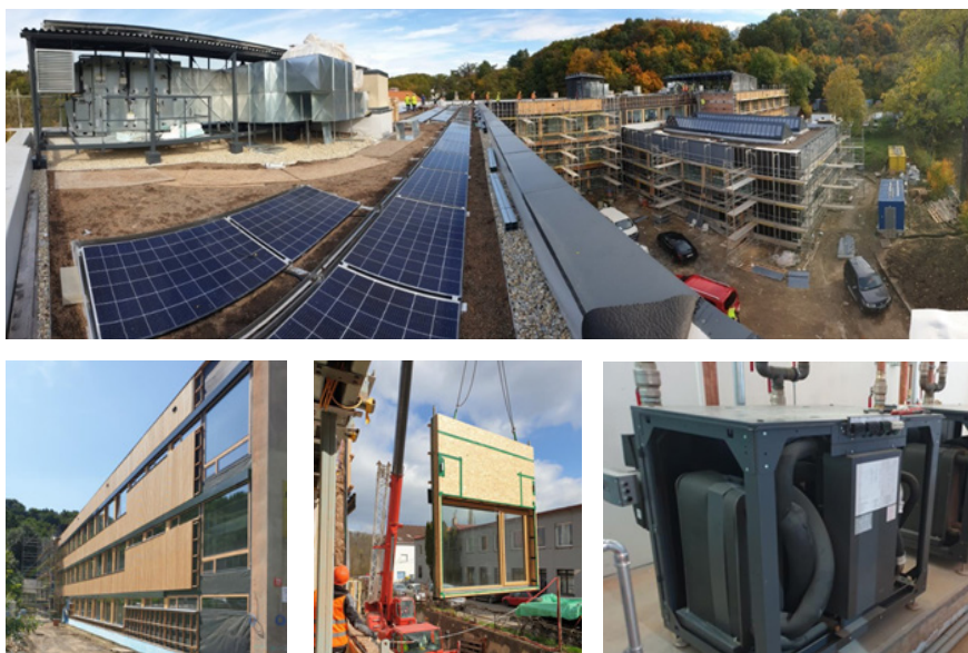
Přestavba střední školy COPTH – Centrum odborné přípravy technicko-hospodářské v Praze – celkový pohled na budovu s FV instalací na střeše (nahore), pohled na východní fasádu (vlevo dole), osazování LOP na bázi dřeva systému ENVILOP (uprostřed dole), tepelná čerpadla jako jeden ze zdrojů energie (vpravo dole) (foto: Jiří Tencar).
