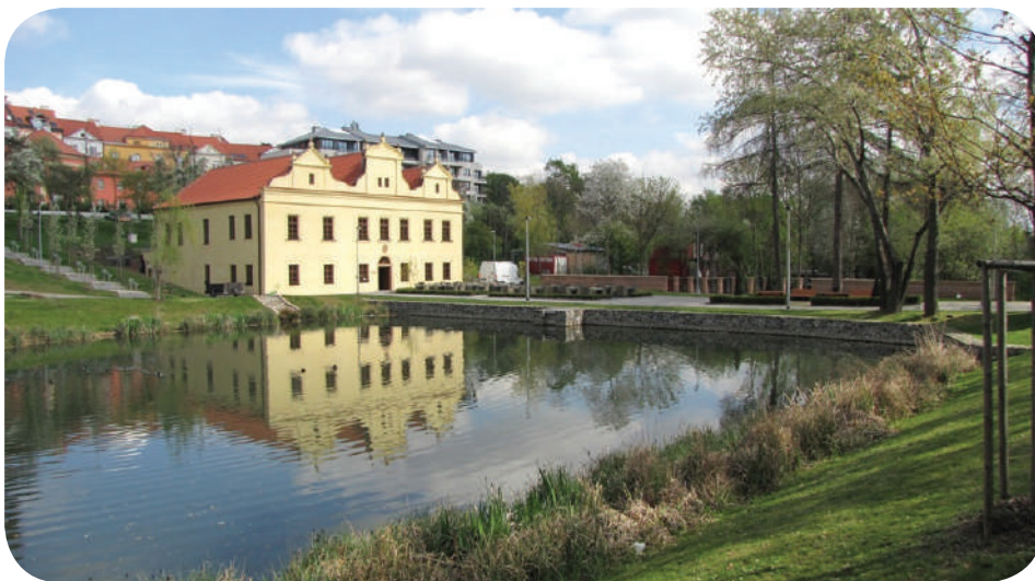
Fig. 22: The Kajetánka Fishpond restoration in Břevnov / Source: praha-priroda.cz
