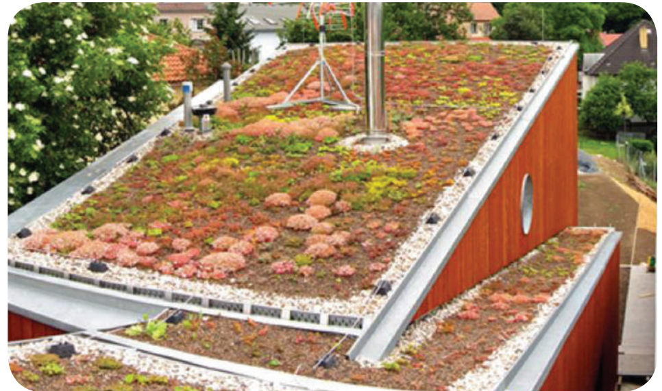
Fig. 27: An extensive green roof, Dům v úžině/House in Gorge, Praha - Jinonice/ Photo Pavel Dostál, 2015
