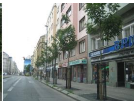
úsek Baranova - Sudoměřská
