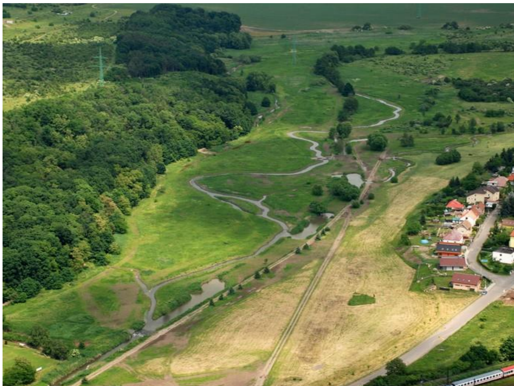
Revitalizace potoka Rokytká v rámci projektu Potoky pro život zdroj: OCP MHMP
