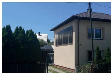
Lidečko: negativní příklad instalace FVS na fasádě a střeše, bez vztahu k charakteru objektu či místa, narušuje celkovou kompozici objektu a významně se uplatňuje ve vnímání širšího území, viditelnost FVS v blízkých i dálkových pohledech, kontrastní barevnost vůči okolním plochám, rušivé odrazy / odlesky na okolní objekty.
