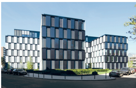
Komplex kancelářských budov Bonneshof Office Center v Düsseldorfu
