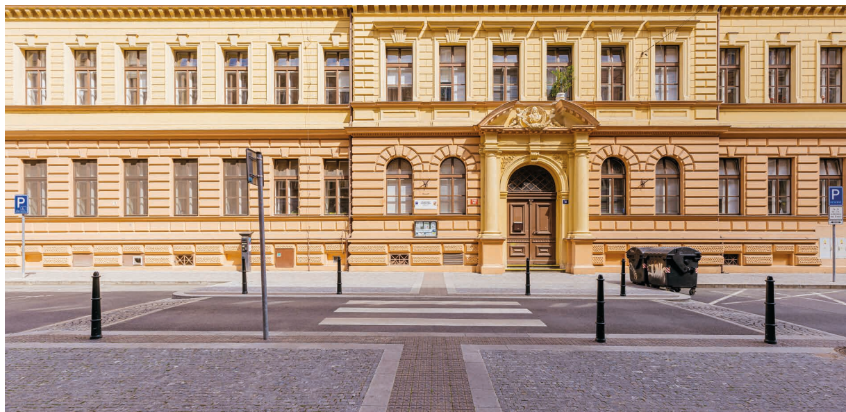
Kultivovaně řešené zvýšení vozovky v předprostoru veřejné instituce.
