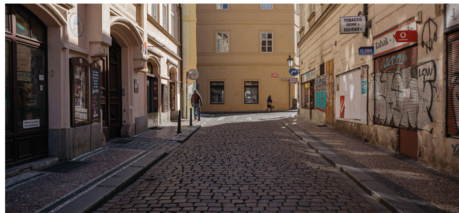
Typická podoba pražského uličního profilu, která se etablovala v druhé polovině 19. století: chodníky s vápencovou mozaikovou dlažbou, žulovými obrubníky oddělené od vozovky, dlážděné křemencovou pražskou kostkou.
