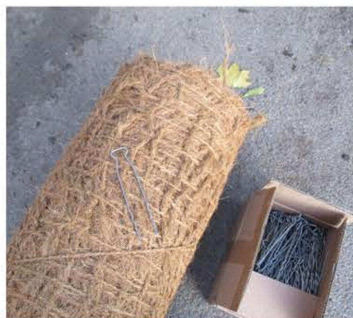
stabilizace svahu kokosovou geotextilií
