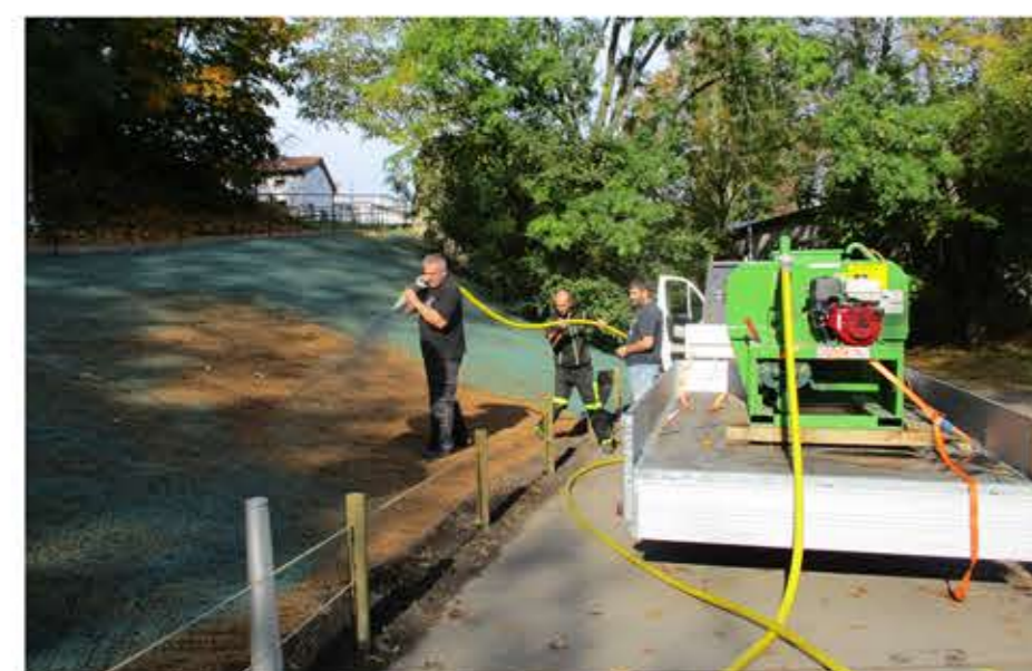
výsev hydroosevem na kokosovou geotextilií
